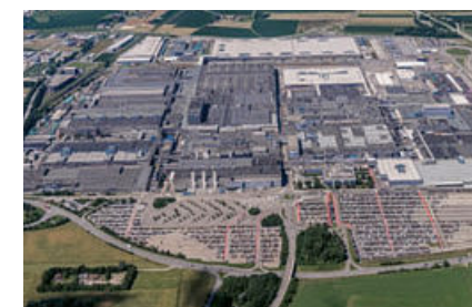
Zakłady w Dingolfing
